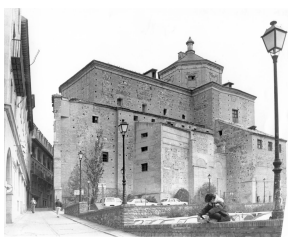
Il complesso di San Marcos prima dell'intervento di trasformazione
